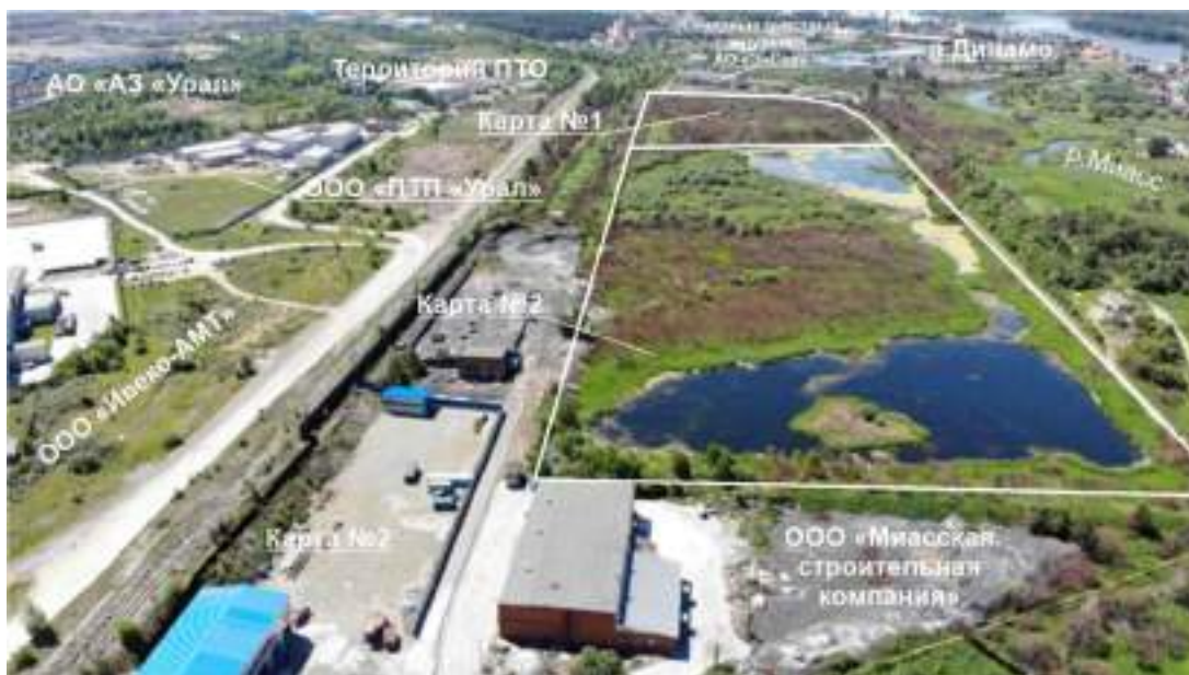
Вид шламонакопителя из точки ф.1 на юго-запад
