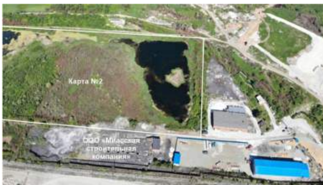
Вид участка работ из точки ф.2 на северо-запад
