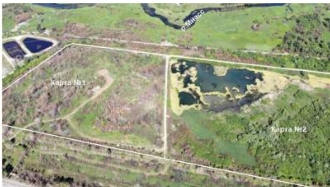
Вид участка работ из точки ф.3 на северо-запад
