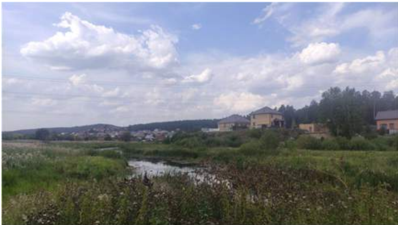
Фото 3 - Вид на русло р. Миасс с северной стороны ограждающей дамбы золошламонакопителя № 1 и жилые дома поселка Динамо г. Миасс (стрелка обозначения направления вида на топоплане №4)
