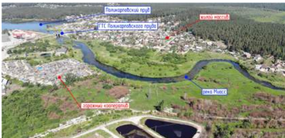
Рисунок 2.5 - Общий вид на нижний бьеф ГТС Поликарповского пруда на р. Миасс
