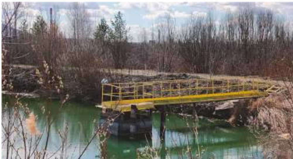
Вид водосбросного колодца шахтного типа с разделительной дамбы между ЗШ1 и ЗШ2
