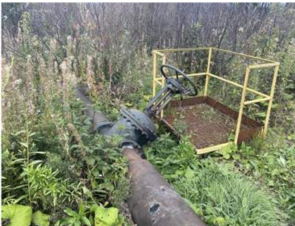
Фото 4 - Отсечная задвижка на сбросном трубопроводе осветленной воды в р.Миасс с площадкой обслуживания.
