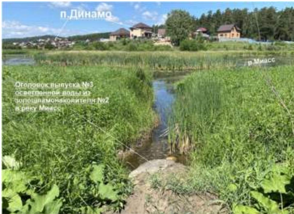
Фото 1 - Выпуск берегового тина, сосредоточенный, оголовок бетонный, место сброса совпадает с береговой линией реки, находится на расстоянии 0,2м выше поверхности реки
