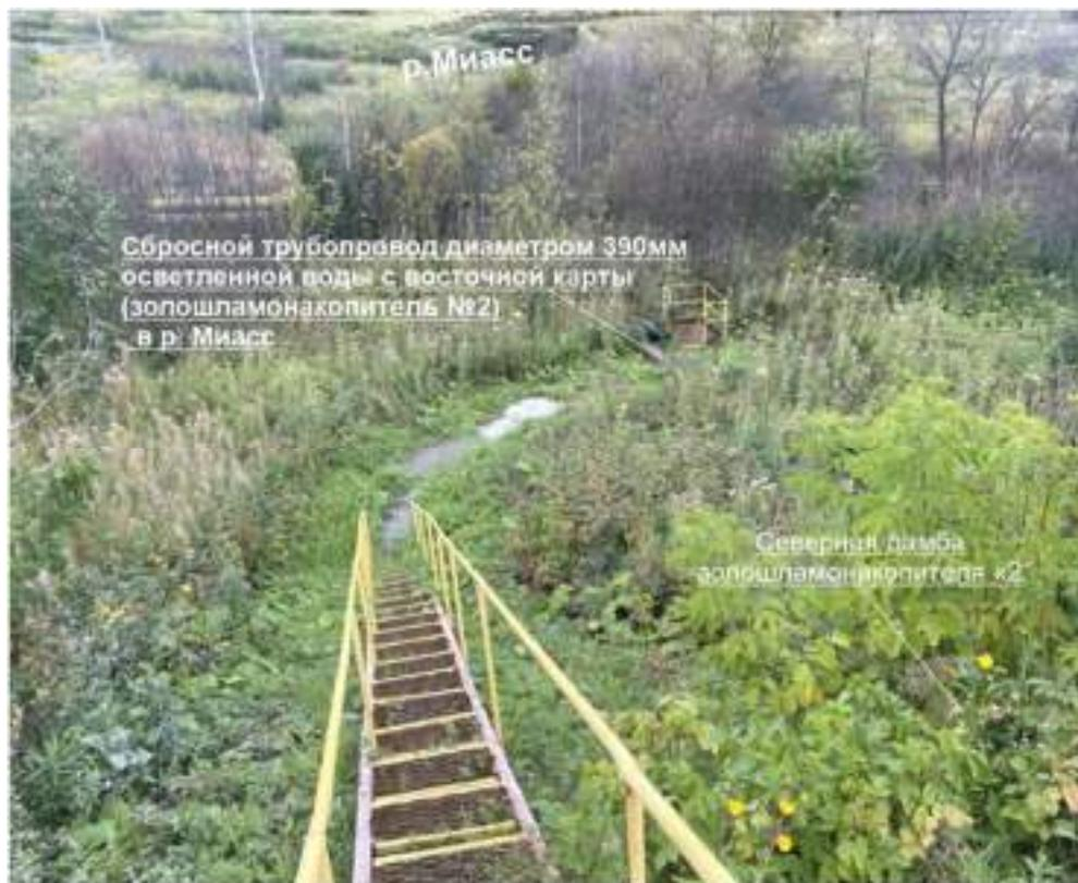
Фото 3 - Вид участка сбросного трубопровода  $\varnothing 390$ мм.осветленной воды с восточной карты шламонакопителя (золошламонакопитель №2) в р. Миасс с лестничным переходом через дамбу и площадкой обслуживания отсечной задвижки на трубопроводе.
